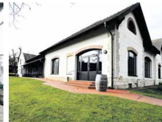
Die alte Schule war das erste Gebäude, das die Kommunard_innen revitalisierten
